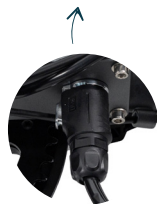
Batterie connectée au contrôleur
