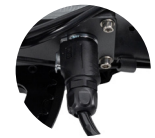
Batterij aangesloten op controller
